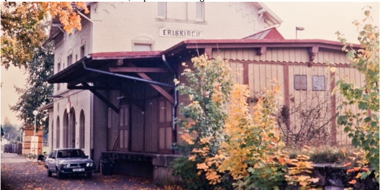
Bahnhofsgebäude vor dem Umbau 1992
